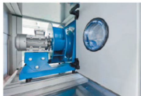
Fig 26: Plug Fan Assembly
